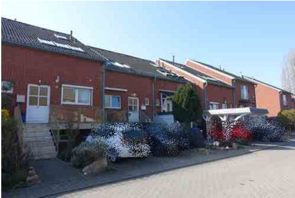
Bild 5: Straßenansicht der Reihenhausanlage
